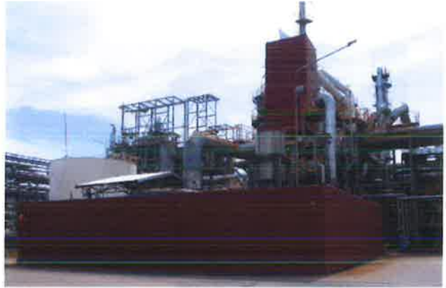
การติดตั้งแผ่นกันเสียงดังจากเครื่องจักร 4140-B1-T1
